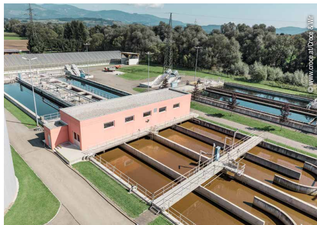
Kläranlagen können zukünftig als Lieferanten für erneuerbaren Ammoniak dienen (im Bild: Kläranlage Knittelfeld und Umgebung als Versuchsstandort für das \text{ReNO}_x -Verfahren)
